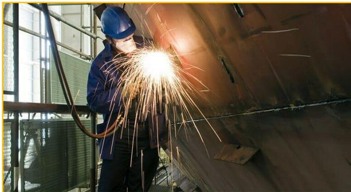
船舶等の建造時に、薄板に熱を加えて溶かす事で接合する
