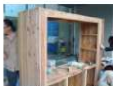
横の壁を取り付け
