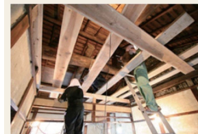
長屋改修工事
