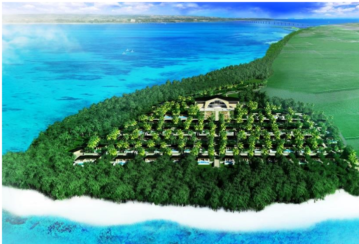
沖縄県宮古島市に建設中の大規模リゾート計画地
